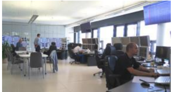
Controlekamer te Evonik Oxeno Antwerpen, met 5 CENTUM besturingscentra en niet minder dan 40 monitoren voor operators
